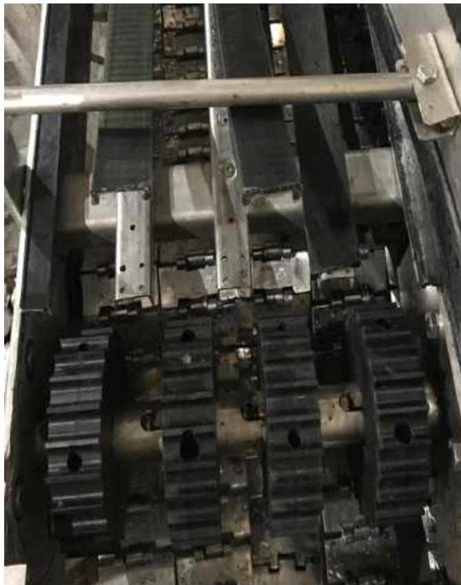
Figura 39 - Trecho de transporte após execução da manutenção
